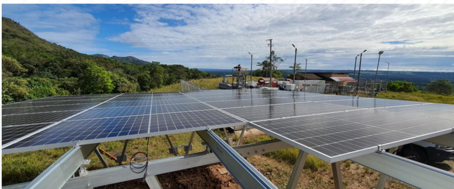
El proyecto de energía fotovoltaica en mención, se compone de 88 paneles solares marca QCELLS Q.PEAK DUO L-G8 de 425W cada uno, instalados sobre una estructura en aluminio tipo carport. Esta estructura sirve a su vez de parqueadero para la locación. La planta cuenta con una solución en acoplamiento en corriente alterna de la marca SMA que alimenta un circuito trifásico 208V con una potencia máxima de 21 KW, con un banco de baterías de litio de última tecnología con capacidad de 60.6 kWh.
